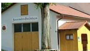
Feuerwehr- und Buswartehäuschen Ratzenhofen
